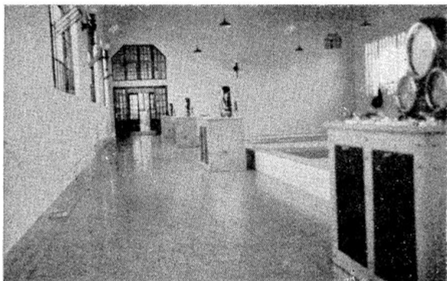
Interior da casa dos filtros, vendo-se 4 unidades filtrantes.
