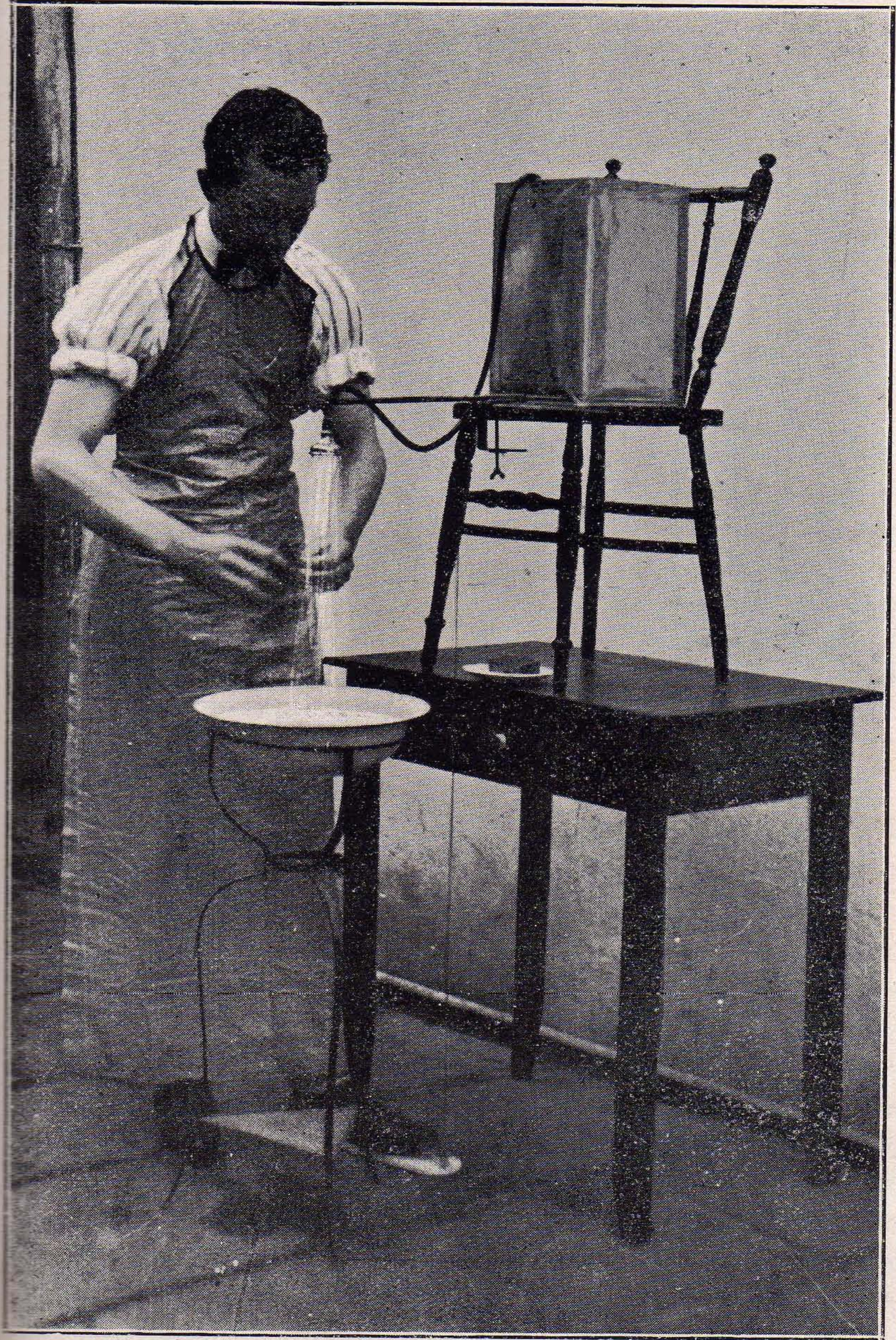
Fig. 4 — Dispositivo para a desinfeccção das mãos em agua corrente
