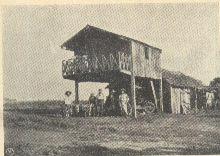
Fig. 9 — Residência de J. A. S. Proximidades das margens do Uruguay. Município de S. Borja, Rio G. do Sul, Brasil. Typo de construção própria dos terrenos inundáveis.
